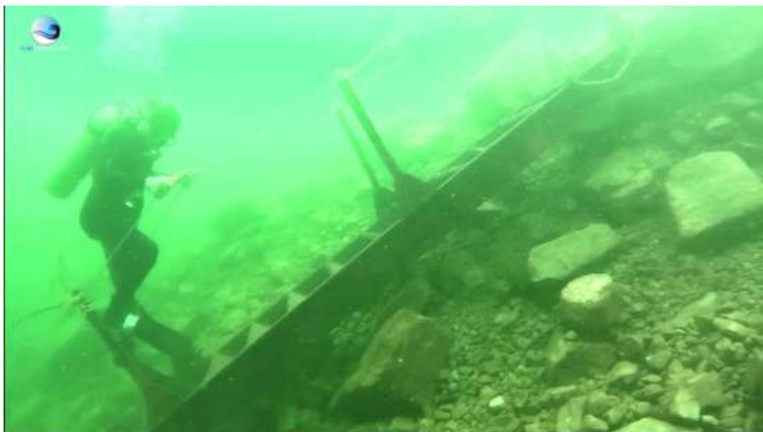
Photo 2 : sous-couche hors tolérances. Profil approuvé sur la base des levés sonar.
